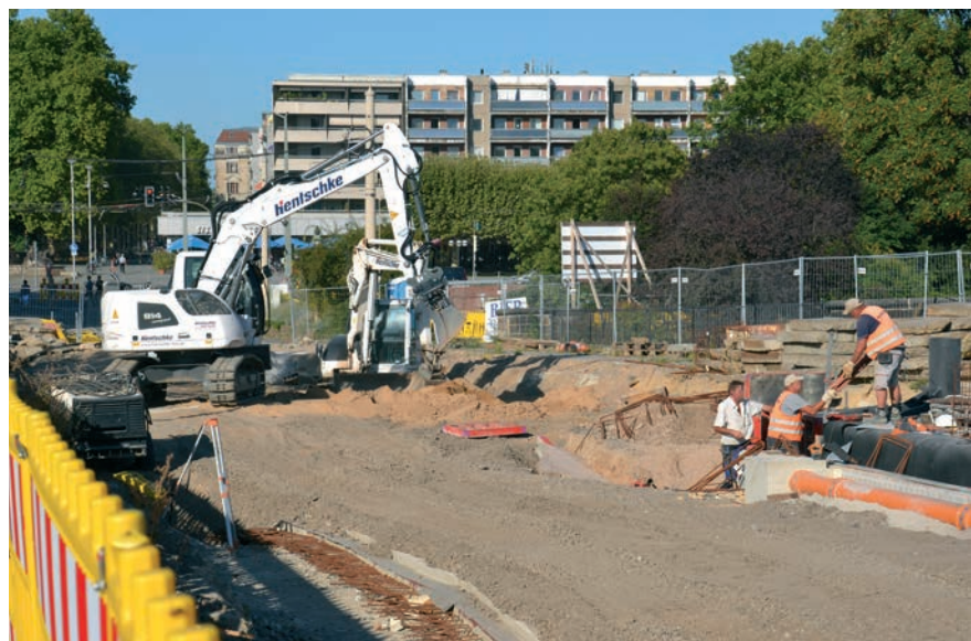
→ Construction site Augustusbrücke
